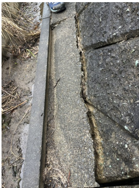
ブロック損傷 楠根における噴砂(損傷)確認地点
